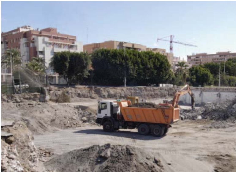
Las obras del futuro complejo de piscinas están ya en marcha
